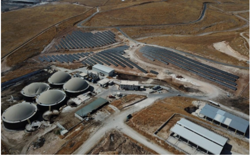
Şekil 3.2. Şanlıurfa ilinde faaliyet gösteren Babil Biyogaz Enerji Sistemleri tesisinin biyogaz üniteleri ve güneş enerjisi panellerini içeren genel yerleşim görünümü.
