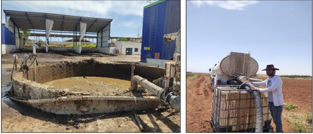
Şekil 3.3. Biyogaz bulamacı merkezi ve takviye işlemine ait görseller
