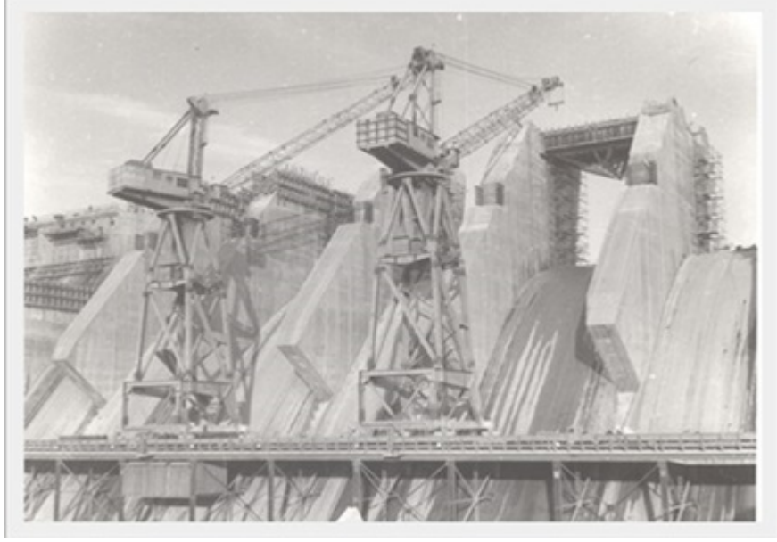
Şekil 4.5. Keban Barajı Yapım Aşmasından Görünüm
