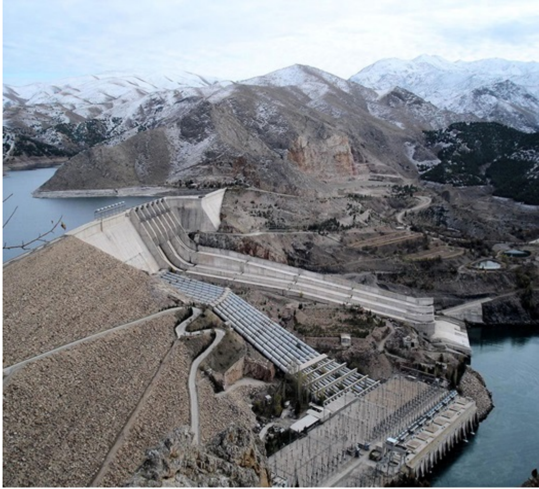
Şekil 4.6. Keban Barajı Kuzeybatı Bölümünden Görüntüsü
