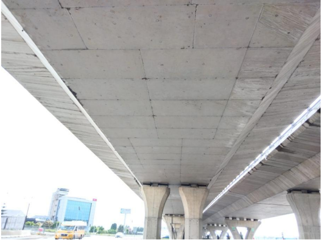
Şekil 1.1. Yerinde Döküm Trapez Kesitli Köprü Kirişi
