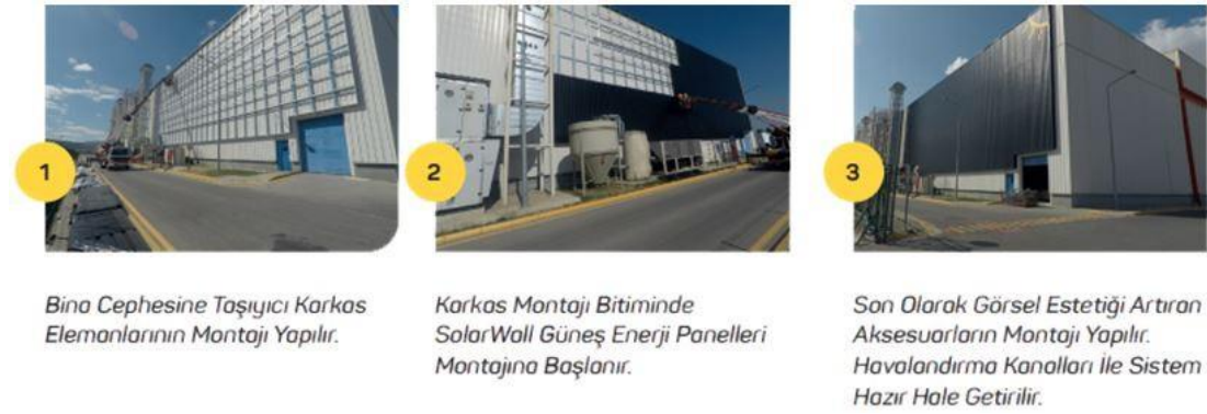
Şekil 3.6. Havalandırmalı Güneş Kolektörü Uygulanma Sıralaması
