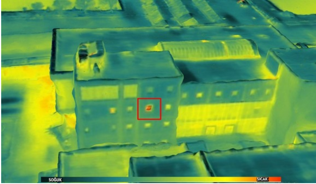
Şekil 4.2. Blok 1 anomali termal model görünümü
