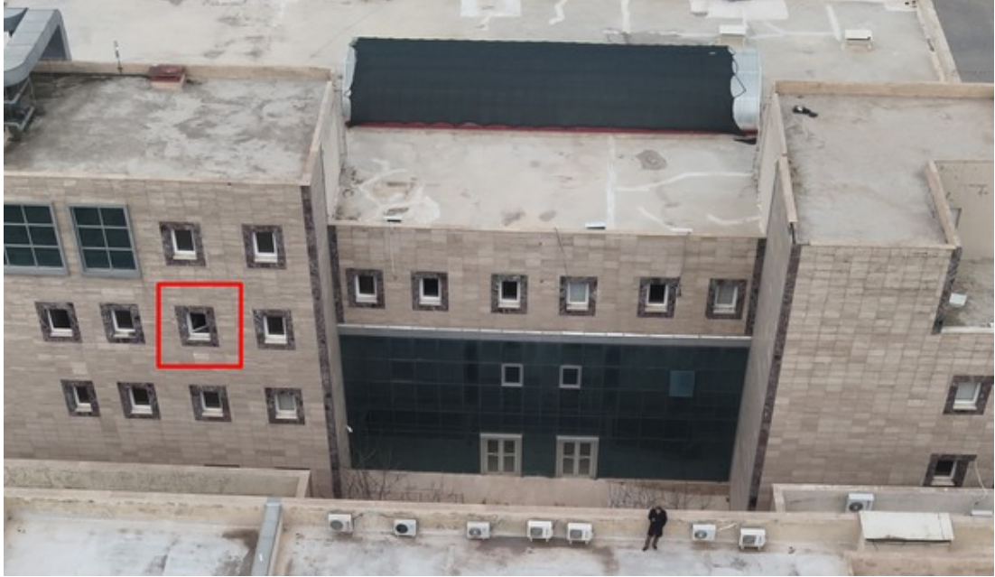
Şekil 4.4. Blok 1 anomalisinin İHA kaynaklı RGB görüntüsü
