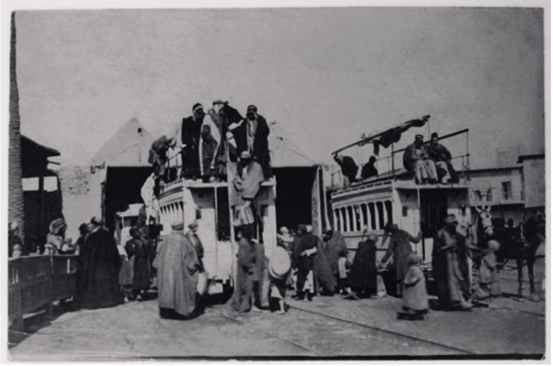
Bağdat-Kazimiye tramvay istasyonu
