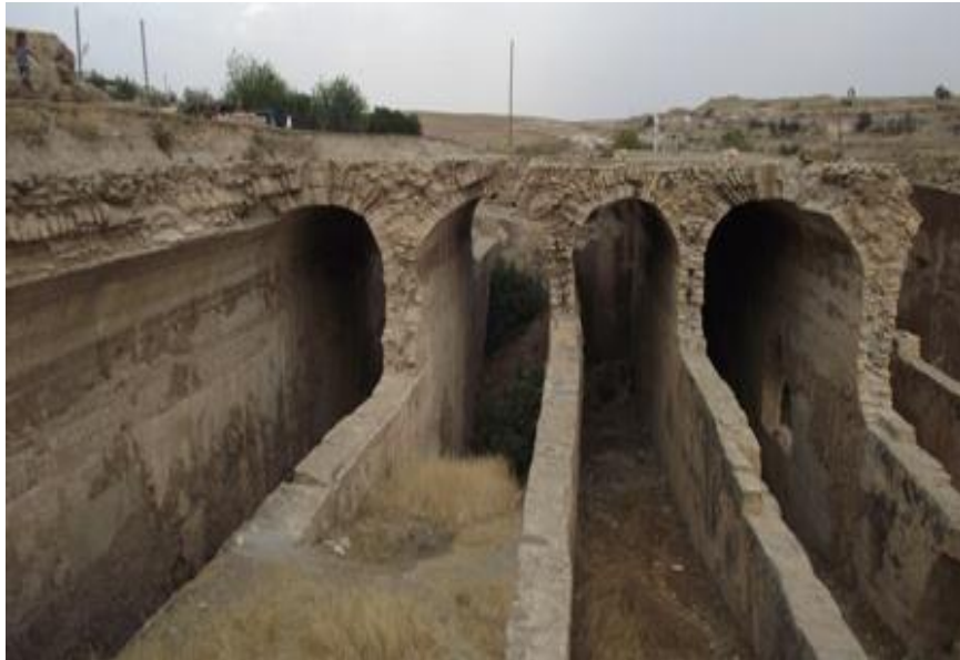
Şekil 4. 6. Dara harabelerindeki su kanalları (URL-28, 2016)
